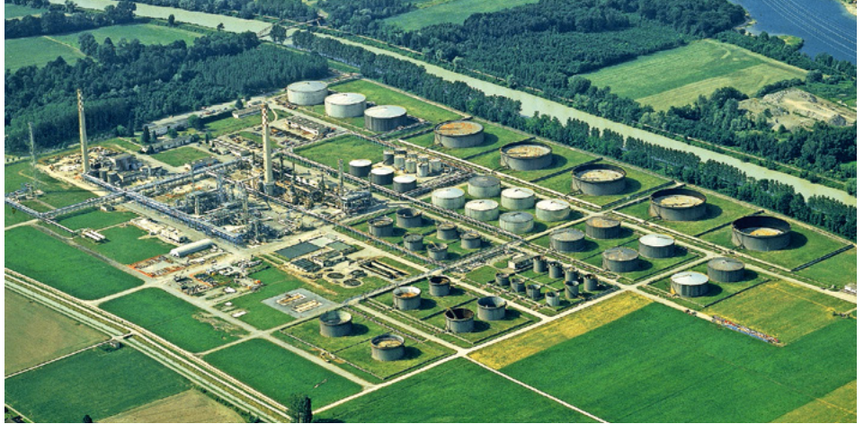
Ehemalige Tamoil-Ölraffinerie in Collombey/VS.
