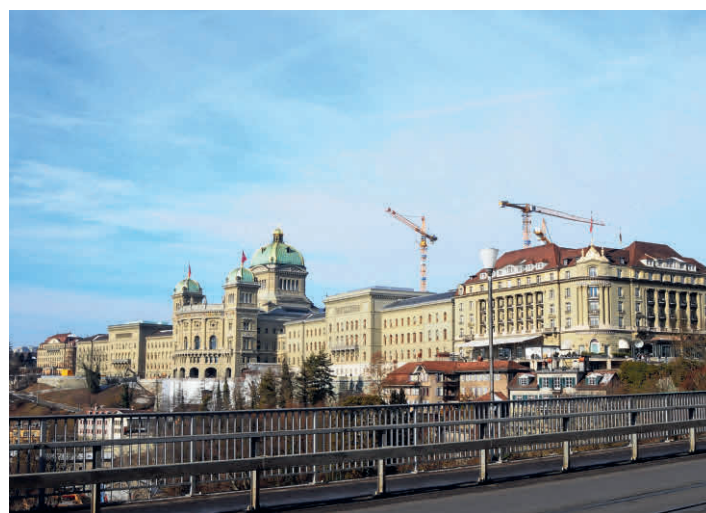
Es gibt nicht nur ums Bundeshaus Baustellen.
